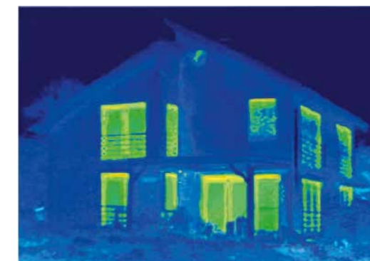
Na de zorgvuldige plaatsing van nieuwe ramen van het Schüco LivIng Variant systeem bewijst de thermografie dat de energie-investering zich goed loont. Het oorspronkelijke energieverlies is nagenoeg volledig weggewerkt.
